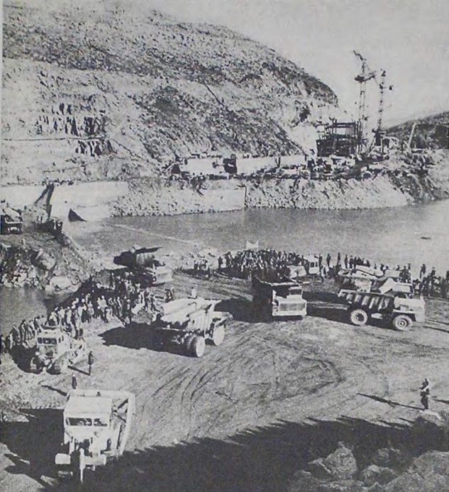
Перекрытие Колымы. Последние «кубики» укрощают течение своеобразной реки.
